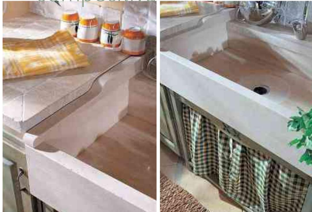
Particolari della realizzazione della vasca lavello con blocchi di travertino oniciato e del rivestimento dei piani in piastrelle 10x10.
